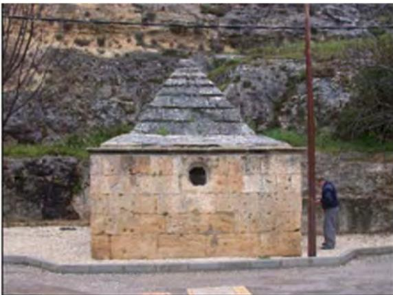
La captación consiste en una galería (con pozos a la superficie) de unos 50 ó 60 m que cruza el barranco y conduce el agua hasta un depósito en el que toda el agua captada es bombeada para abastecimiento.
